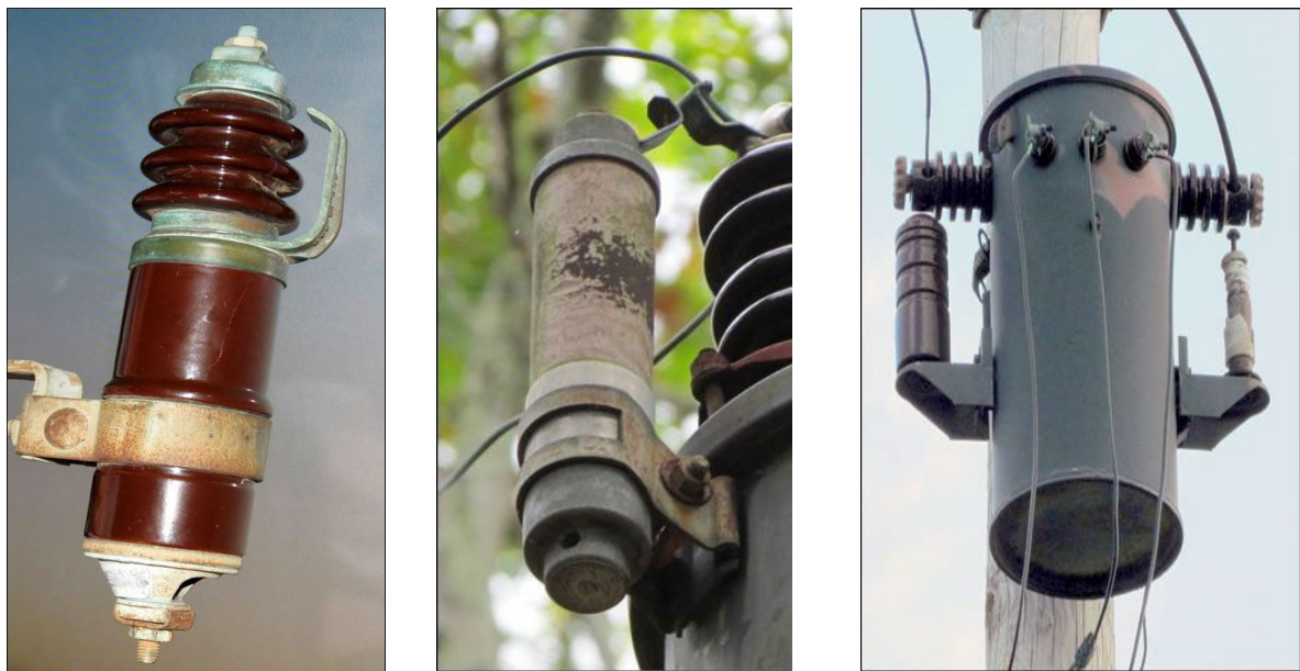
Slika 3. Odvodnici prenapona iz 1940. proizvodnje „ Joslyn Supply Co. “ (lijevo), i 1950. proizvodnje „ GE Still “ (u centru) još uvijek u pogonu. Odvodnik prenapona sa ventilom za ispuštanje gasova – „oduvnim kućištem“, rješenje „ General Electric “-a iz 1922., proizveden 1945. i bio u upotrebi do 2011. (oštećeno desno kućište – prikaz desno)
