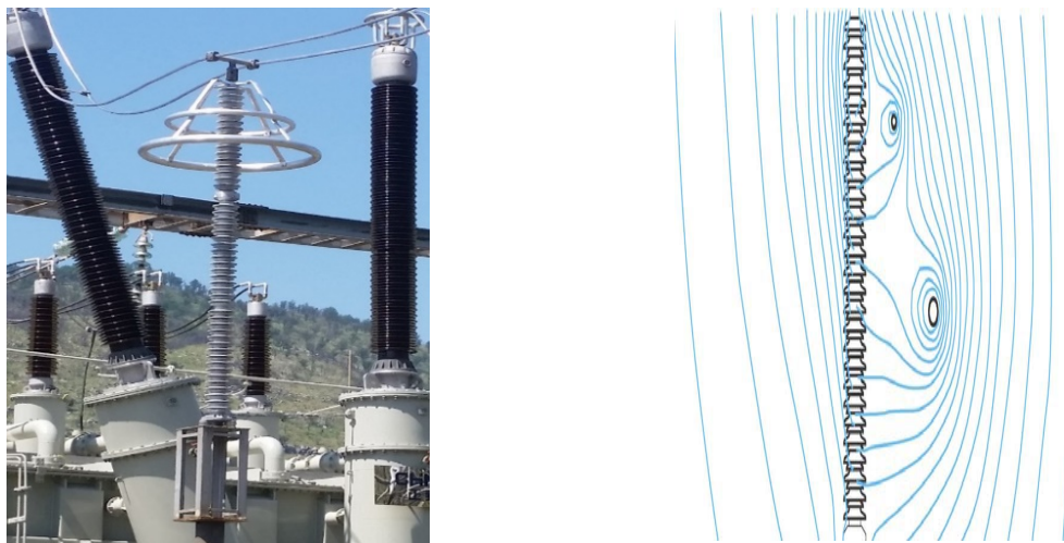
Slika 11. Prsten za oblikovanje polja i naponsko naprezanje kućišta odvodnika
